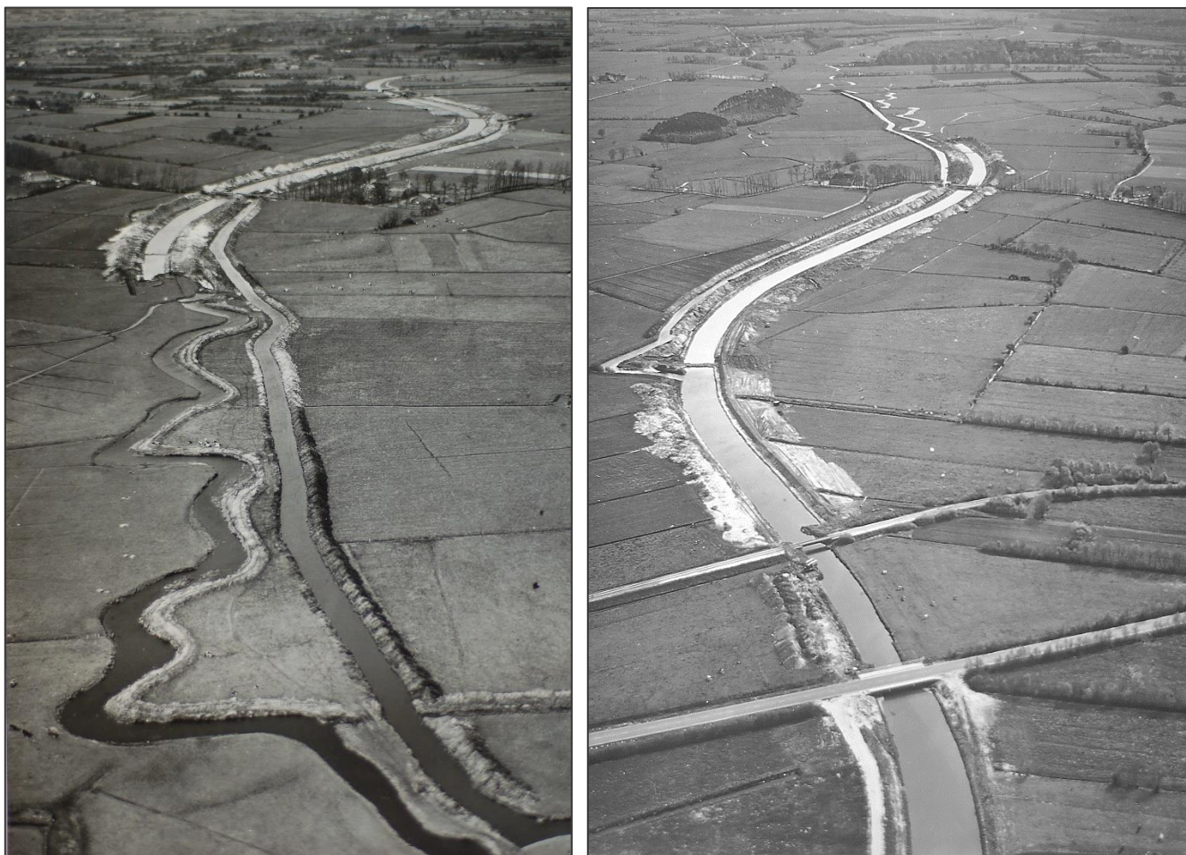
Figuur 4. Kanalisatie van het Peizerdiep (1962-1963). Rechts: richting het noorden. Links: richting het zuiden.
