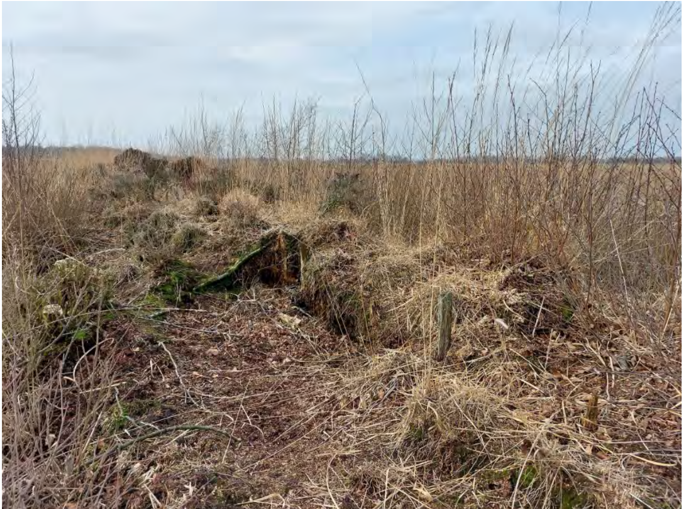
Figuur 11-69 Op de kades treedt steeds weer opslag van houtige gewassen op. Ze liggen hoger en zijn daarom droger. De uitstekende houten damwanden bemoeilijken het beheer van de kades. Foto: André Jansen
